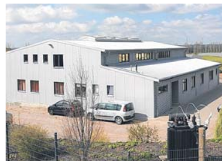
Hallen, wie diejenige der Firma Selbmann Elektroanlagenbau im Tauschaer Gewerbegebiet, werden von Beschäftigten der Leuteritz Anlagenbau gebaut. Aber auch Metallzäune gehören zum Leistungsspektrum.
